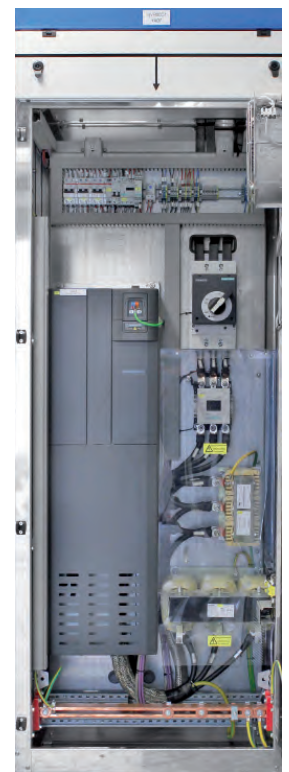
Abgangsfeld mit Frequenzumrichter ▲
