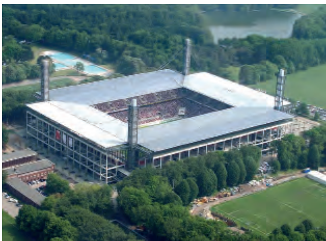
Rhein Energie Stadion, Köln ▲
